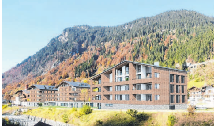
Rund 19 Millionen Euro wurden für das ArlbergResort Klösterle veranschlagt. JÄGER BAU
