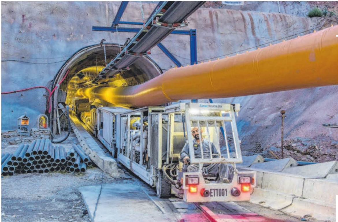
Nach 35 Baumonaten freut sich Jäger Bau über den erfolgreichen Durchschlag des Aposeelemis Tunnels auf Kreta.
