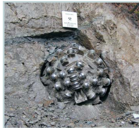
Sondierstollen Achrain Österreich / Austria
