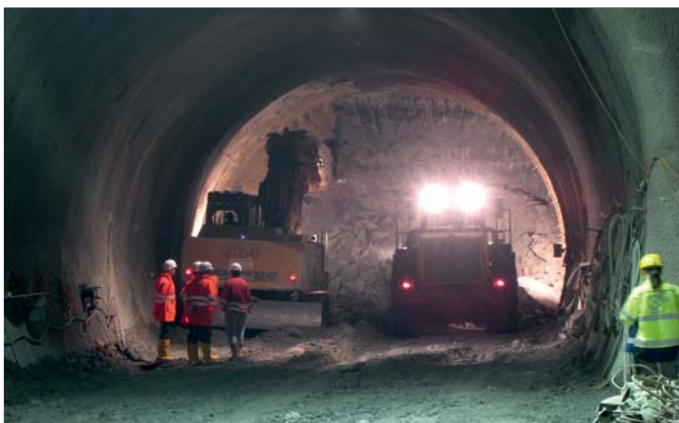
Sprengvortrieb / Drill & blast excavation
