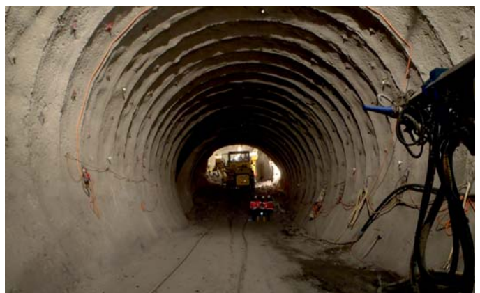
Sprengvortrieb Nord / Drill & blast excavation north
