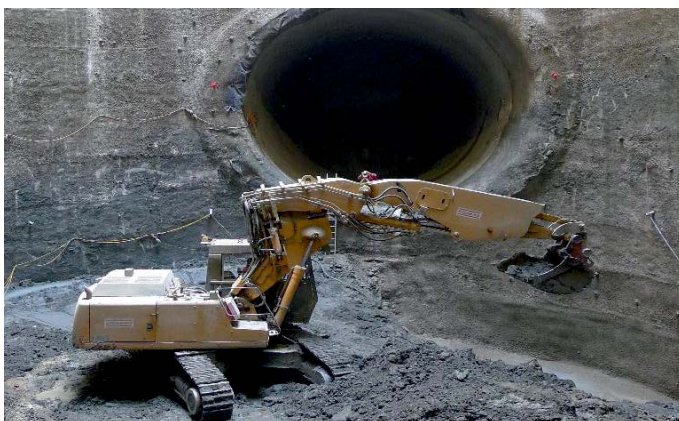
Schutterschacht / Mucking shaft
