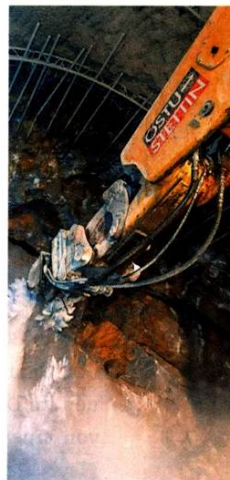
STETIG Seit Dezember 2020 wird in Kärnten am neuen Kraftwerk gebaut.
